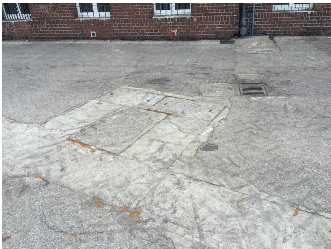
Fot 8. Istniejąca nawierzchnia oraz wpust deszczowy (widoczne przebudowa sieci ciepłowniczej)
